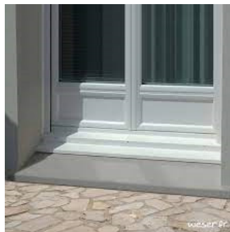
Le seuil de la porte
